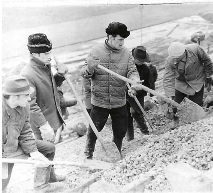
Строительство стадиона имени Ленинского комсомола. Пермь, 1967 год
